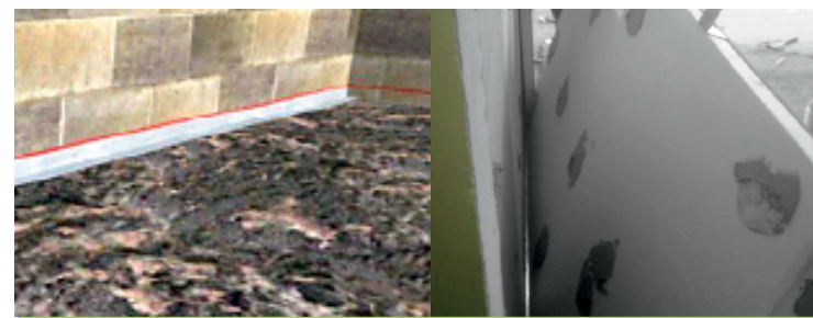
Fijar ángulo Z para interconectar paneles Sellar los bordes, aplicar acabados
