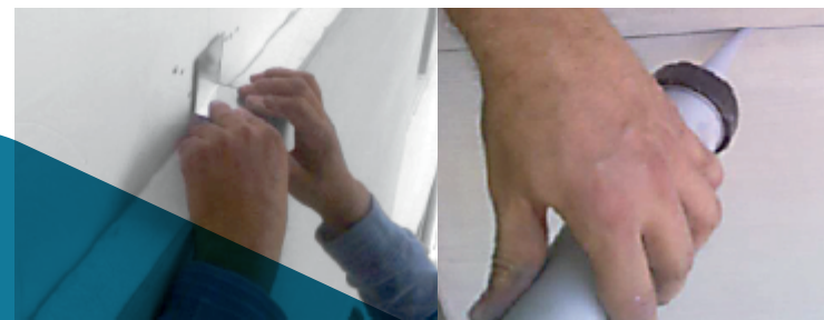
Fijar ángulo Z para interconectar paneles Sellar los bordes, aplicar acabados
